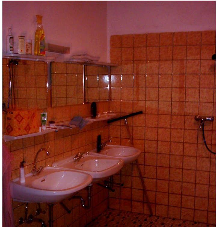
Auch schon ganz schön lange her: Der Waschraum vor der Renovierung
