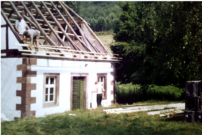
RENOVIERUNG DES „GÖTTINGER HAUSES“ 1973
