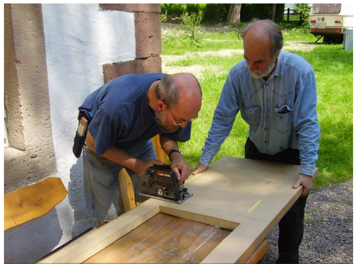
RENOVIERUNG DES „GÖTTINGER HAUSES“ 2006
